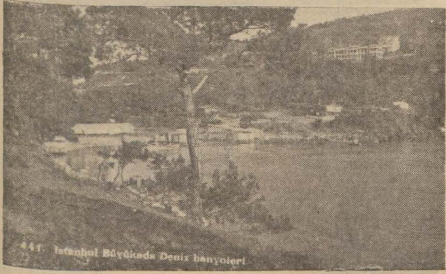
Adaları Güzelleştirme Cemiyeti tarafından işletilecek Yürükali plajı
